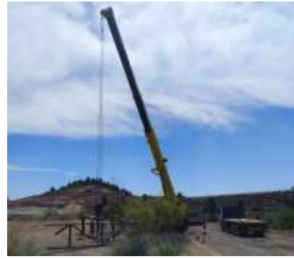
Foto 35: Traslado Pórtico de Señales
