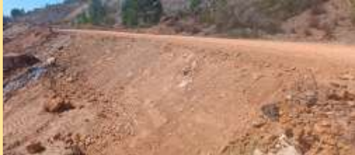
Foto 52: Reparación de taludes de caminos
