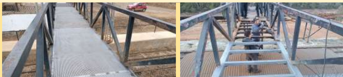
Fotos 50 y 51: Restauración de la plataforma del puente peatonal de los Frailes
