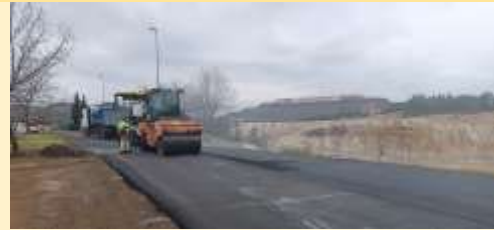
Foto 55: Asfaltado en carretera de Peña de Hierro
