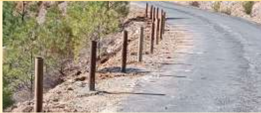
Foto 54: Colocación de bolardos
