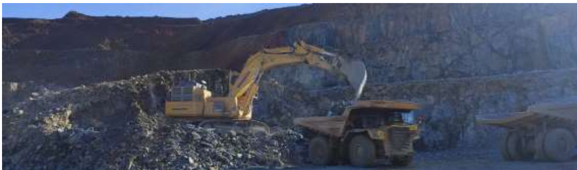
Foto 36: Trabajos en Masa San Dionisio
