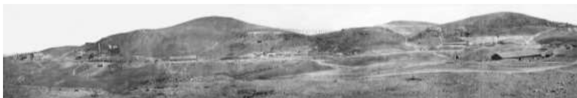
Foto 40: Sala de ES.21049.AHMFRT_A9_1102. Masa San Dionisio. 1883.
