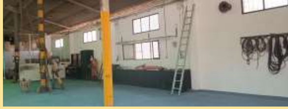
Foto 53: Trabajos de mejoras de varias zonas de la nave de talleres
