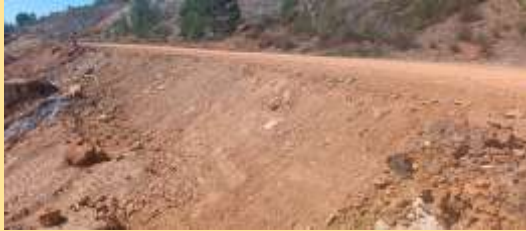
Foto 54: Reparación de taludes de caminos
