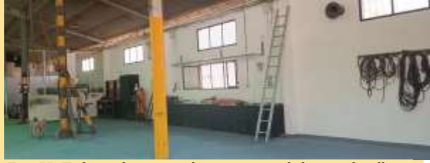
Foto 55: Trabajos de mejoras de varias zonas de la nave de talleres
