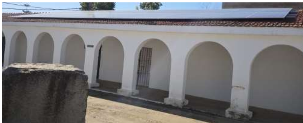
Foto 16: Instalación placas solares fotovoltaicas
