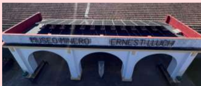
Foto 69: Instalación Placas Solares Autoconsumo. Museo Minero
