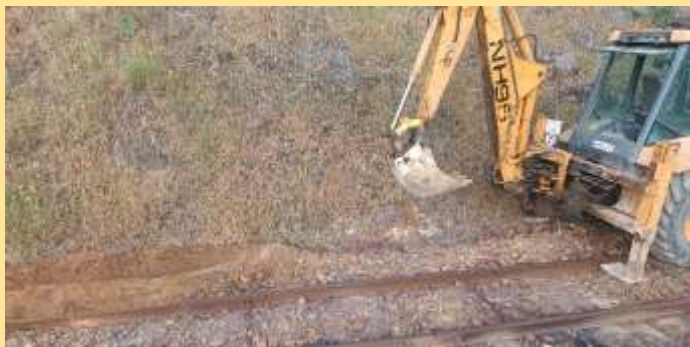
Foto 59: Trabajos en el sistema viario del FFCC
