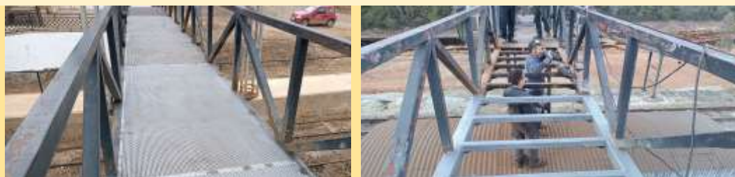
Fotos 52 y 53: Restauración de la plataforma del puente peatonal de Los Frailes
