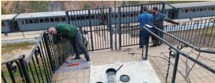
Foto 56: Trabajos en la escalera de acceso al FFCC en la estación de Talleres Mina
